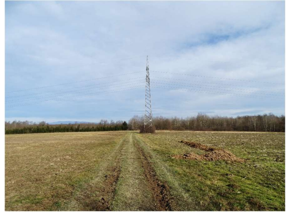
Stup dalekovoda na čestici sjeverno od obuhvata plana
